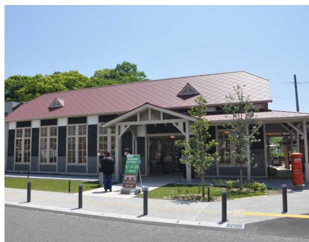
再利活用工事を終えた旧湯浅駅舎
