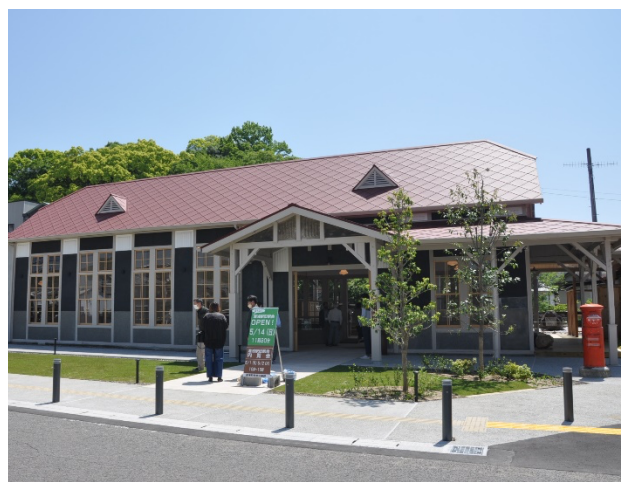
再利活用工事を終えた旧湯浅駅舎
